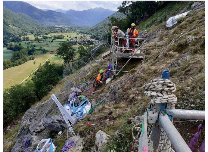
Zone de purge des blocs rocheux
