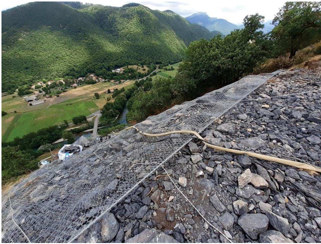
Mise en place du filet de stabilisation des blocs présents dans le versant
