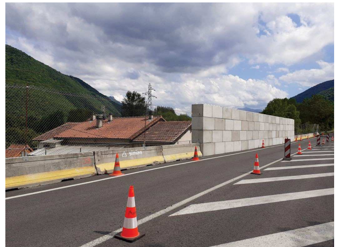
Bloc bétons type "LEGO" protection des habitations
