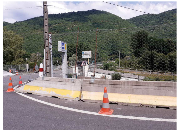
Figure 1: blocs type "GBA" complété par grillage
