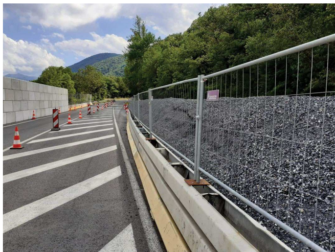
Merlon de matériaux calcaires en pied de versant
